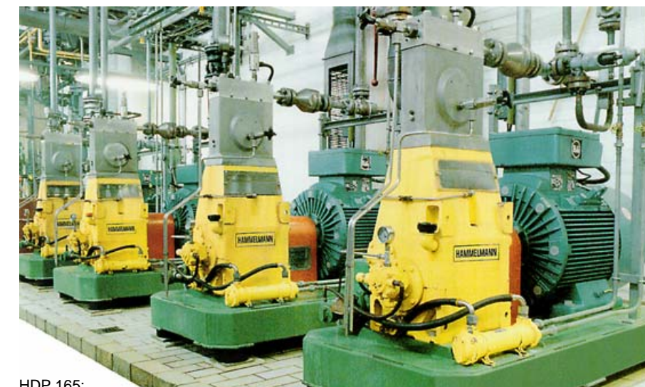
HDP 165: Pompe de process à 3 plongeurs
