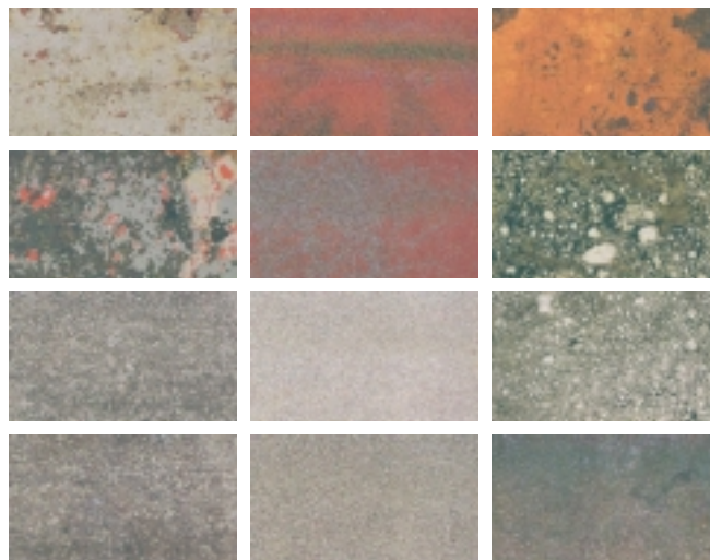
Old paint Red epoxy shop primer Rust
