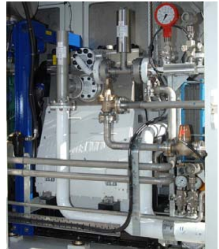
Pumpen-Aggregat HDP 755 Fördern von Meerwasser Temperatur: 86° F / 30°C Chloride: 35.000 ppm Betriebsdruck 2600 psi - 180 bar Fördermenge 365 gpm - 1380 l/min
