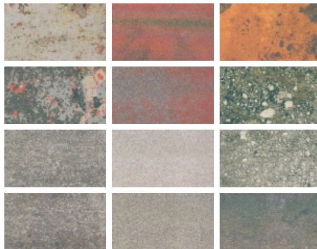
Old paint Red epoxy shop primer Rust
